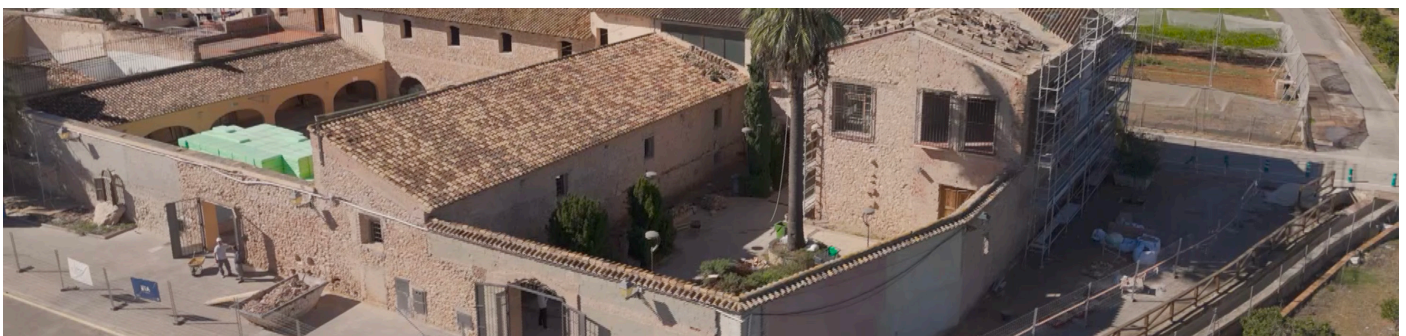
Avance de las obras de la reforma integral de la Torre del Virrey
