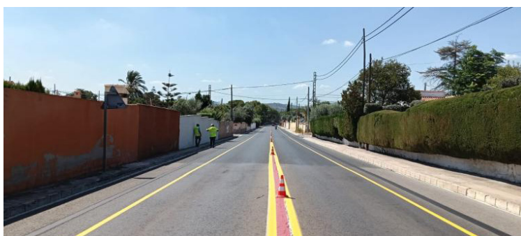
Inicio de las obras de mejora de la seguridad vial y pacificación en la CV-336
